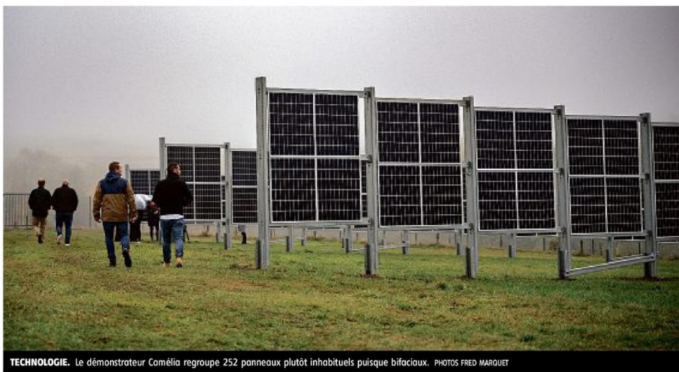
TECHNOLOGIE. Le démonstrateur Camélia regroupe 252 panneaux plutôt inhabituels puisque bifaciaux. PHOTOS FRED MARQUET
